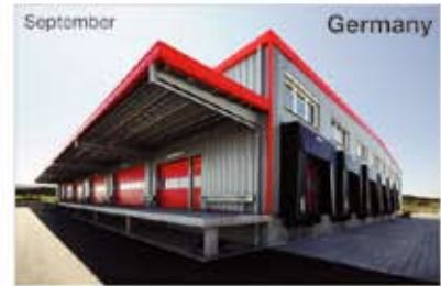
Builder: Wertbau GmbH & Co. KG. Customer: Sprenger Architect: Wertbau GmbH & Co. KG.
